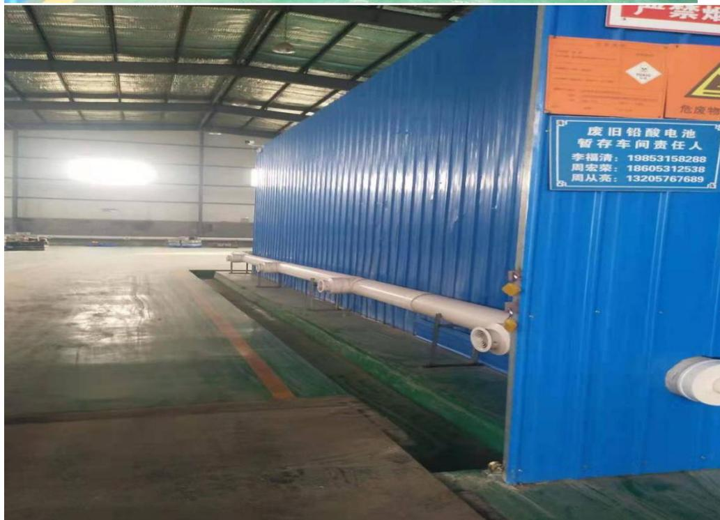
危险废物贮存区域液态危废贮存区域有导流沟防护，危废库地面高于室外地坪，不会发生液态危废外溢和雨水灌入情况，地面已做防渗处理门口张贴标志标牌。
