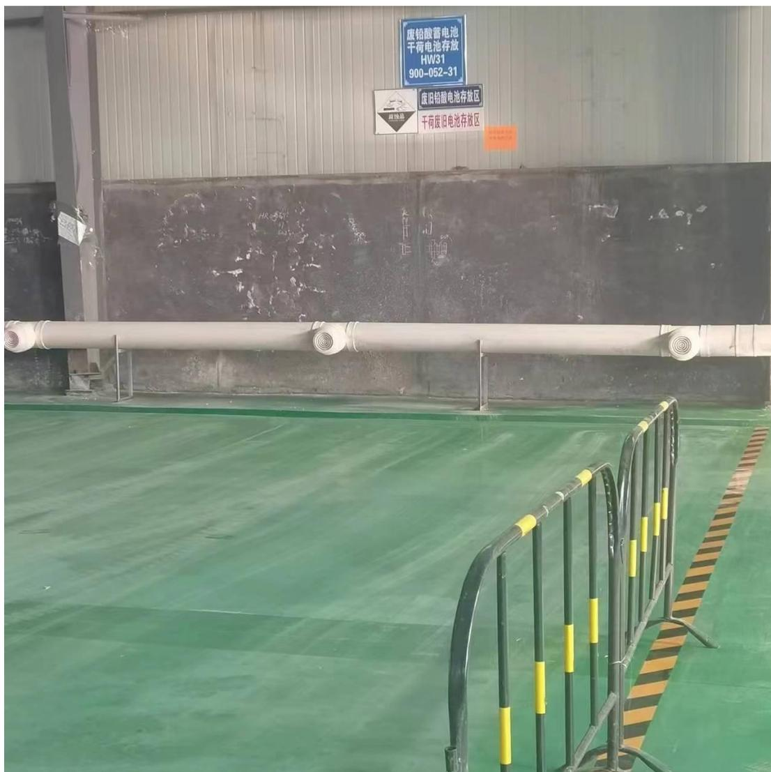
危险废物贮存间采用隔断墙的方式进行分区贮存，同时废铅酸电池暂存间地面贴有分区线、栅栏，根据种类不同分区存放，每个区域现场张贴存放类型、危险标识等。对于破损电池采用塑料托盘，塑料托盘具有防渗漏效果，并在塑料托盘上放有防渗漏的盒子，确保破损电池不会渗漏。
