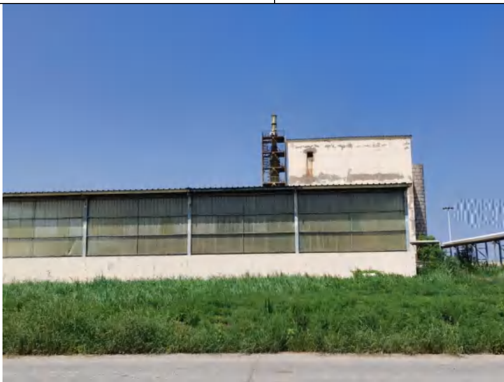
沼气锅炉排气筒 DA002
