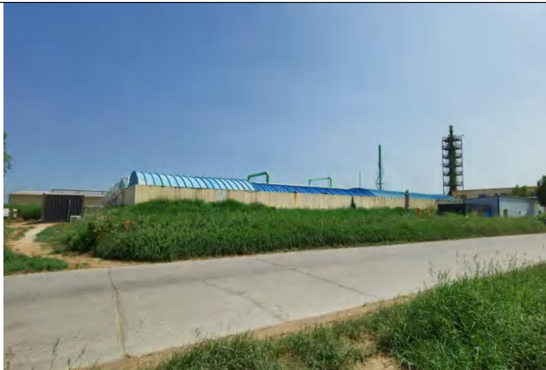
污水处理站现场照片
